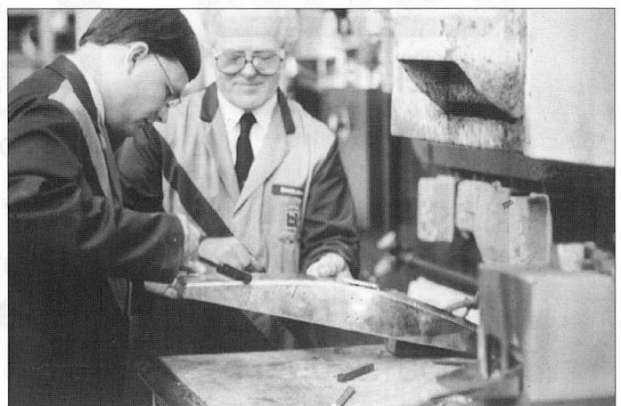
Löten eines Kühlergrills
